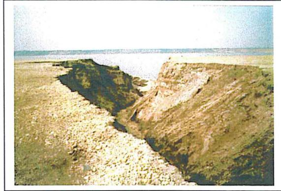
Abb. 5.2: Markante Erosionsrinne in der Ostböschung des Baufeldes Ib - Tagebau Merseburg-Ost (Foto: Frotscher 1997) **(PT XIV)**
