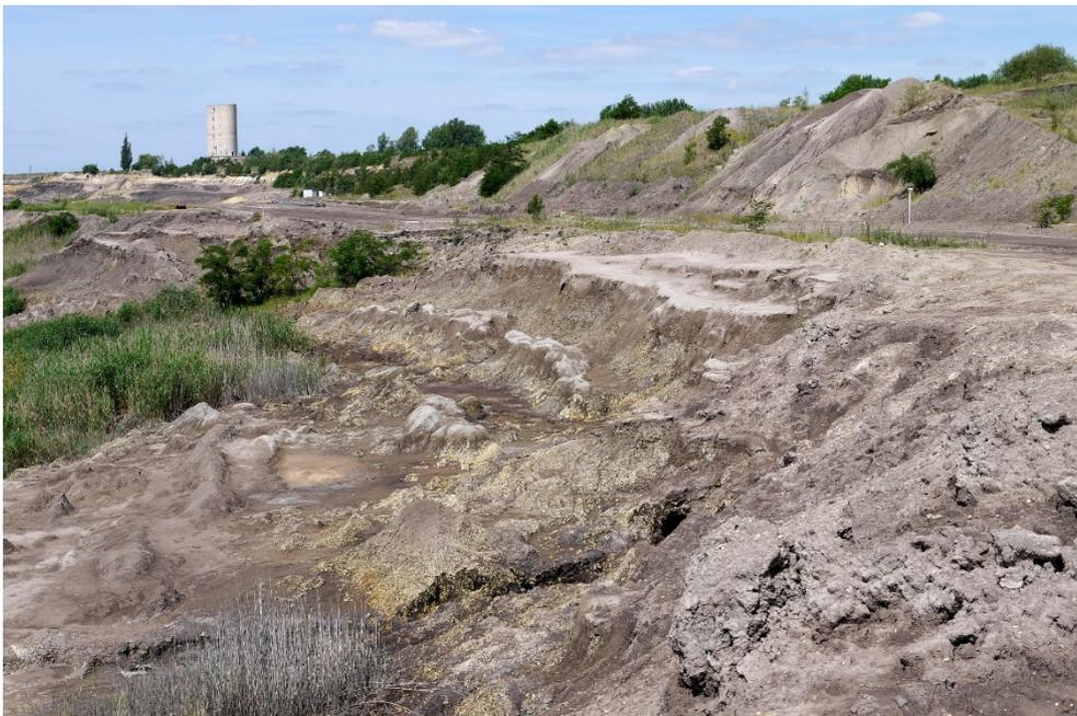
*Abbildung 1: Zeitverzögerte Bruchvorgänge im nördlichen, gewachsenen Endböschungssystem/Baufeld Westen III (Foto: Anne Meffert)*
